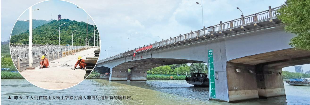
▲ 昨天，工人们在锡山大桥上铲除打磨人非混行道原有的磨损层。
