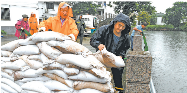
昨天，黄巷街道党员志愿者在前村社区一低洼居民区用沙包筑临时堤坝，力保老自然村不遭内涝。（刘芳辉 摄）
