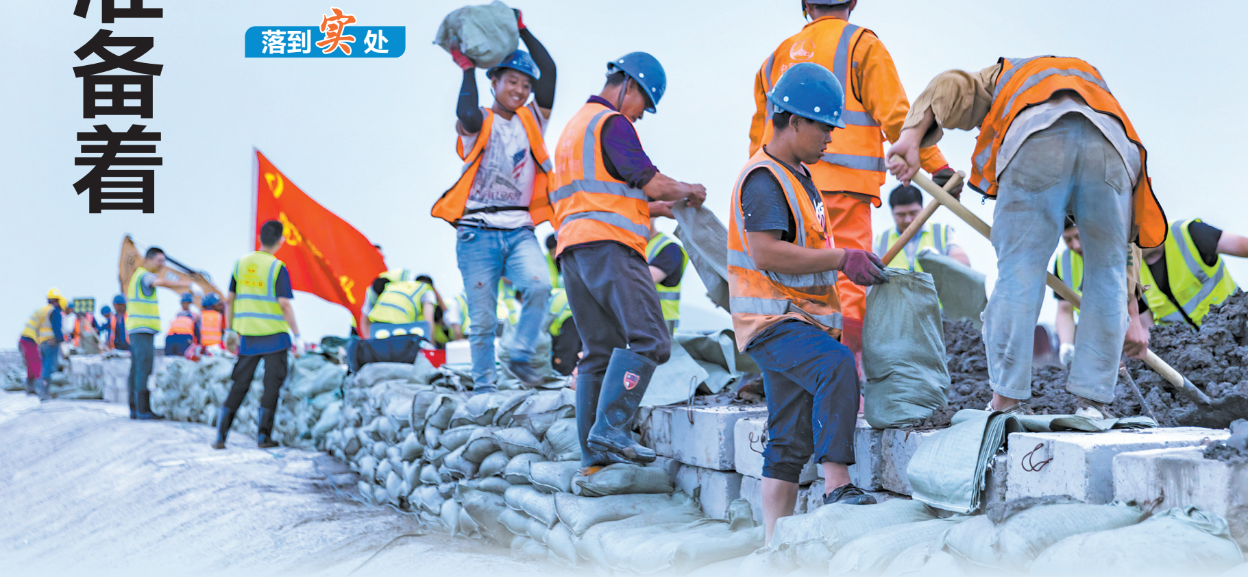
▲昨天凌晨，苏锡常南部高速公路太湖隧道南泉段项目部自发成立“党员突击队”和“青年突击队”共计190余人开展防汛抢险工作。突击队同时调集挖机1台、铲车3台、发电机2台，赶在大雨来临前，开展基坑围堰加高筑坝工程，经过5个小时的紧急行动，隧道围堰加高50厘米，填充土袋、预备应急沙袋近万个，提升了围堰的防洪能力和安全系数。（顾庆赞、通讯员蔡朝阳 摄）
