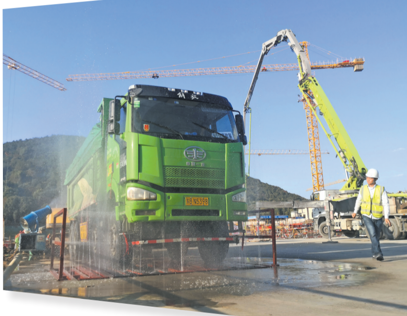
昨日,位于山水东路上的儿童福利院项目工地,工程车进出接受自动冲洗。(张元摄)
