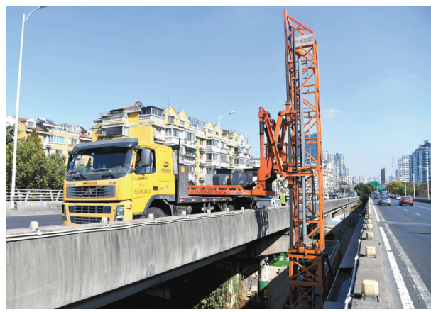
近日,技术人员操作检测车对金城大桥开展“体检”。冬季来临,我市市政等部门对城市交通主干道上的相关大桥启动检测,确保桥梁安全和城市交通畅通。(刘芳辉 摄)
