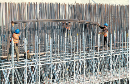
14时05分，彝族钢筋工在脚手架上紧张忙碌。
