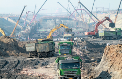
13时55分，繁忙的太湖隧道工程施工现场。
