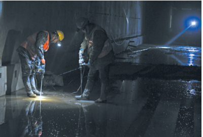
16时15分，彝族工友在漆黑狭小的隧道中隔墙管廊里做钻孔作业。
