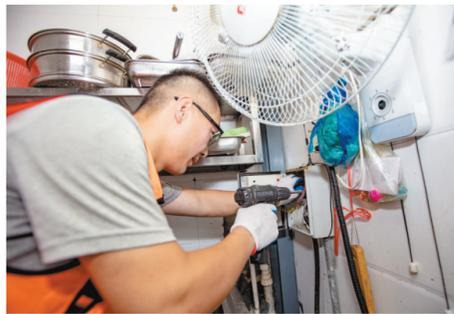
昨日,第三方公司在吴江区餐饮商户更换报警器。为加强对安装“智慧燃气”平台用户的检修维护,新吴区住建局委托第三方公司中科智远采用“定期+不定期”模式展开对智慧燃气报警器的检查维护,确保商户燃气使用安全。(宗晓东 摄)
