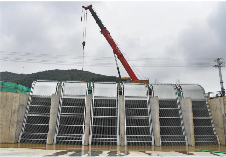
昨天,刚完成水下部分完工验收的省级重点工程——环太湖大堤剩余工程无锡滨湖段马圩四号排涝站重建工程在青山环抱中显得格外醒目。该泵站始建于上世纪七十年代初,设备和体量已无法适应当下防汛需要,为此,中央、省、市和滨湖区共同投资2000多万元对泵站进行拆除重建,安装六台大功率全贯流潜水泵,将排水能力从原来的每秒4.4立方米提升到现在的每秒15.5立方米,使之与太湖堤防相得益彰,共同构成可靠的防洪排涝系统,确保整个马山地区不遭水患。(刘芳辉 摄)
