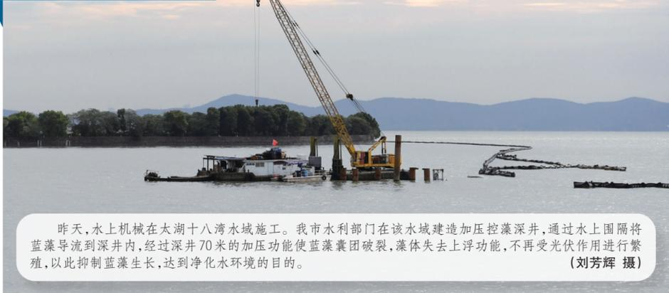
昨天,水上机械在大湖十八湾水域施工。我市水利部门在该水域建造加压控藻深井,通过水上围隔将蓝藻导流到深井内,经过深井70米的加压功能使蓝藻囊团破裂,藻体失去上浮功能,不再受光伏作用进行繁殖,以此抑制蓝藻生长,达到净化水环境的目的。(刘芳辉 摄)
