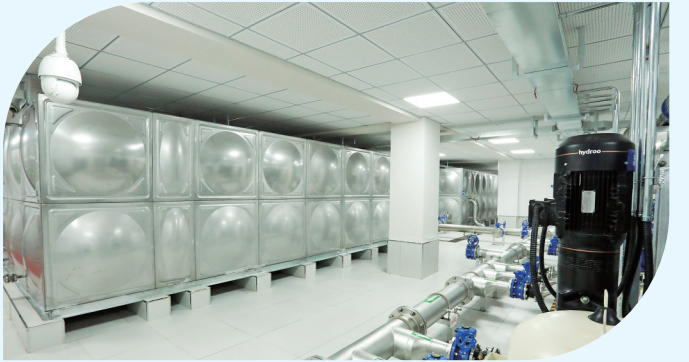
二次供水设施改造
