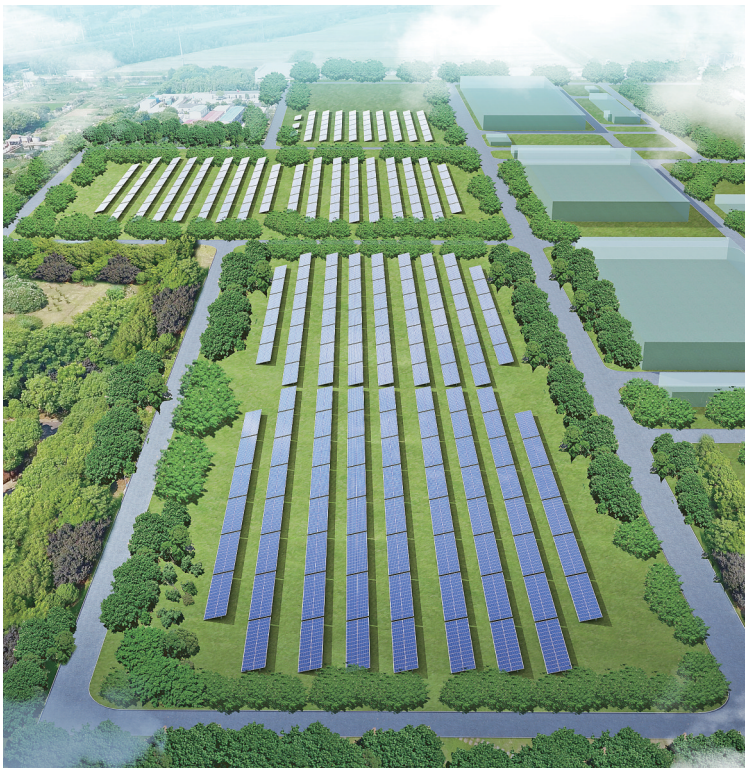
锡澄水厂分布式光伏发电项目
