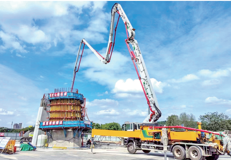
24日上午，由中铁四局施工的江阴滨江路快速化改造工程黄山路斜拉桥下塔柱混凝土浇筑完工，标志着斜拉桥施工转入钢塔施工阶段。该斜拉桥总长248米，主塔高88米，采用漂浮体系，为全线重点控制工程。 （刘芳辉 摄）
