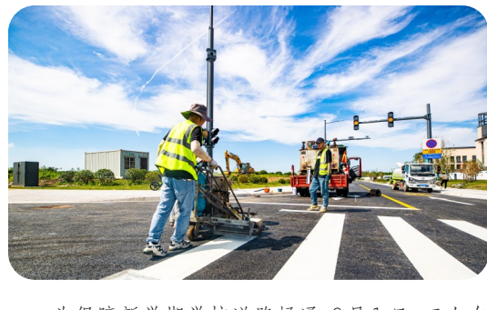
为保障新学期学校道路畅通,9月1日,工人在新吴区金鸡实验学校前的中庆路加紧收尾工作。中庆路位于新吴区金鸡实验学校正门口,是孩子上学、家长接送孩子的必经之路。(宗晓东 摄)
