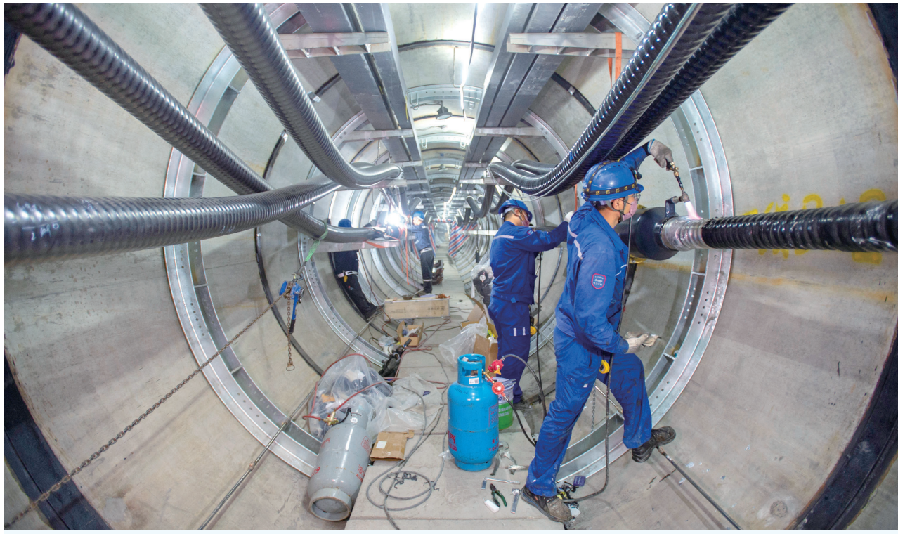
为配合无锡西物物流园区工程建设需要，连日来，国网无锡供电公司组织人员加班加点开展220千伏惠张线路迁移改造入地工作。本次工程需敷设220千伏地下电缆线路双回路共计长2600余米，拆除旧杆塔5基、新立杆塔2基，工程计划5月中旬完工。图为昨日施工现场。(潘正光、陈佳伟 摄)
