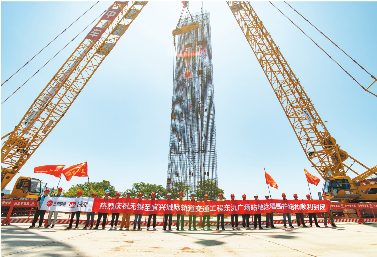
6月29日上午,随着最后一幅地连墙浇筑完成,S2线东沭广场站121幅地连墙施工顺利完成,标志着全线首座车站围护结构实现封闭,助力无锡轨道交通新线建设再提速。 (李一芳 摄)
