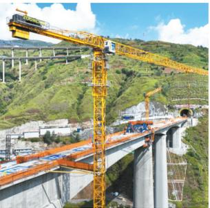
9月7日在云南省昭通市鲁甸县江底镇拍摄的渝昆高铁江底牛栏江特大桥合龙现场。当日，由中铁二局承建的渝昆高铁江底牛栏江特大桥实现全桥合龙。大桥的合龙标志着桥墩占比高达87.4%的渝昆高铁建设取得关键性突破，为全线按期建成通车奠定了坚实基础。(新华社发)
