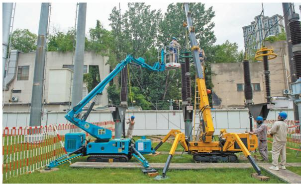
近日，工作人员在220千伏江溪变电站，借助履带式蜘蛛吊车和履带式蜘蛛斗臂车更换避雷器。国网无锡供电公司秋季检修中，大力实施机械化作业，充分利用多种特种设备在狭小或复杂地形环境中开展作业，不仅提高操作过程的稳定性，也极大保障了工作人员的人身安全。（潘正光 摄）
