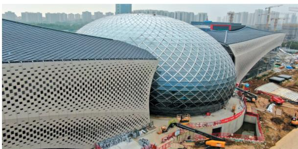
本报讯 9月29日上午,无锡交响音乐厅项目施工现场热火朝天。在阳光照射下,镶嵌上玻璃的“太湖明月”呈现出了流光溢彩的效果。从项目建设方中建八局获悉,截至国庆前夕,“太湖明月”造型的音乐厅主厅外部的玻璃幕墙已全部安装到位,主厅东西两翼的龙鳞屋顶也全部铺设完毕,这意味着无锡交响音乐厅主厅的外部建筑已基本建设完成。“从今年元旦音乐厅的主厅开始
