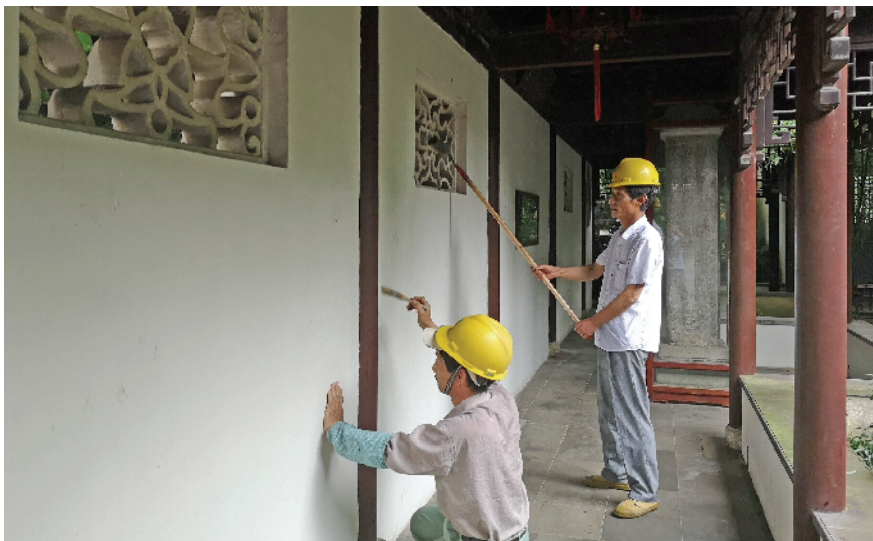
锡惠园林文物名胜区的二泉书院,近日进行建筑防霉施工。
