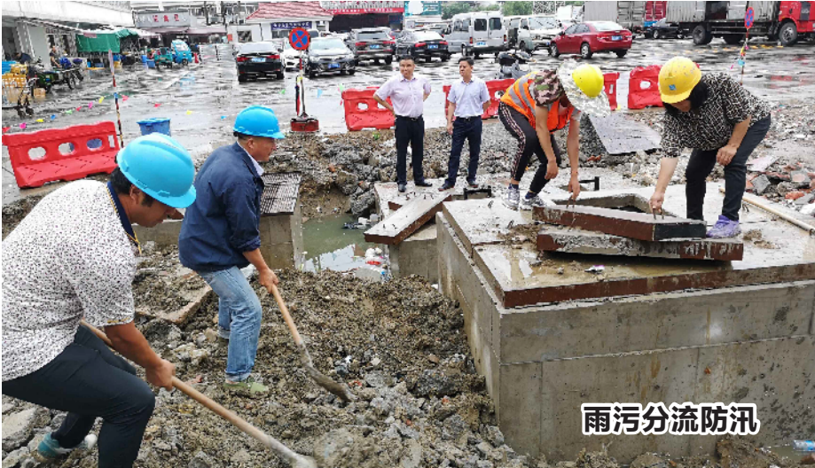
昨天上午，工人在崇安农贸市场进行雨污管网施工，针对市人大代表控源截污排查工作中，发现市场原有雨污管网因年久管道破损有雨污合流现象，尤渡社区自筹资金对原有管网整体改造，整改后无污水流入河道及雨水管网，有效提高防汛能力。（陈大春 摄）
