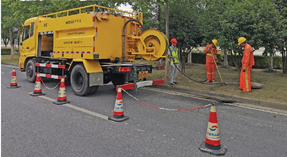
驶，调整摄像头对管道内的不同区域进行拍摄，以此判断管段是否出现堵塞等情况。此外，声呐检测仪则可以完成管道机器人不具备的“潜水作业”技能，在有大量液态水的管道中，声呐检测仪通过超声波对管道淤积和破损情况进行精准探测定位，便于养护人员“对症下药”。
