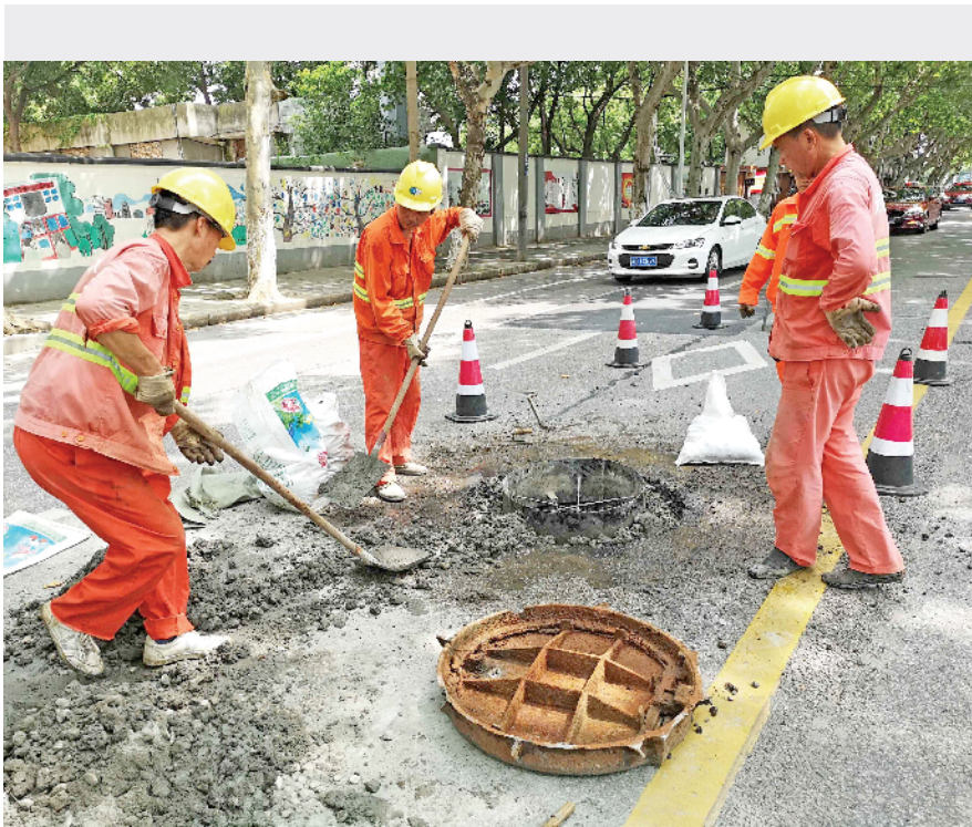
昨天，市排水公司的工人在通惠西路更换破损的窨井盖。连日梅雨，锡城路面破损严重，市政工人利用天好的有利时机抢修，确保市民出行安全。（陈大春 摄）
