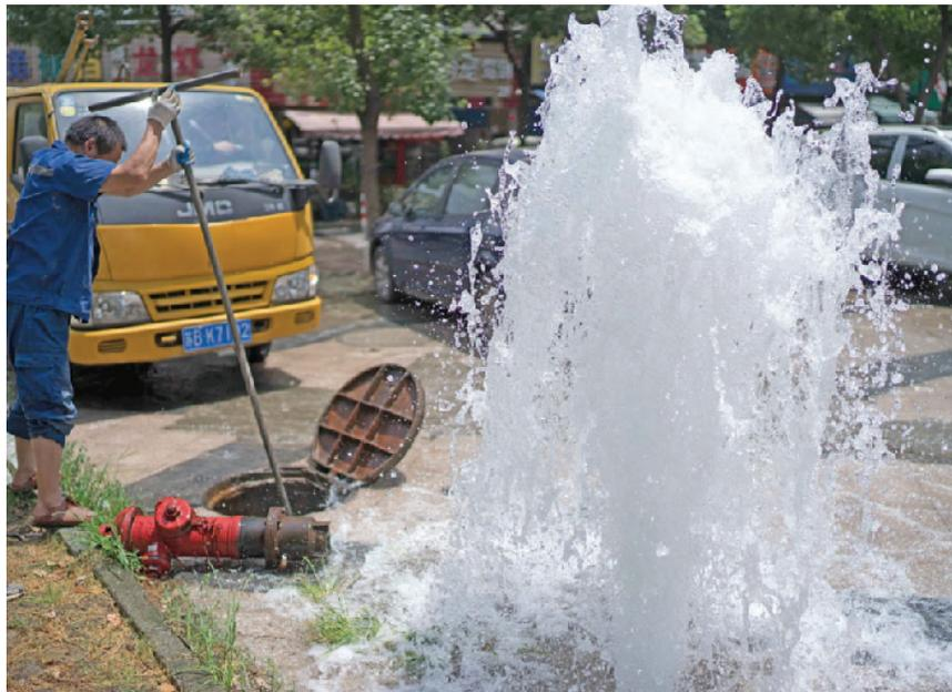
昨天,惠峰新村3号门对面路边的一个消火栓被一辆汽车不慎撞断,水流瞬间喷涌而出,持续了约半小时。抢险队员到场后,很快关闭了一旁的阀门,止住了喷水。
