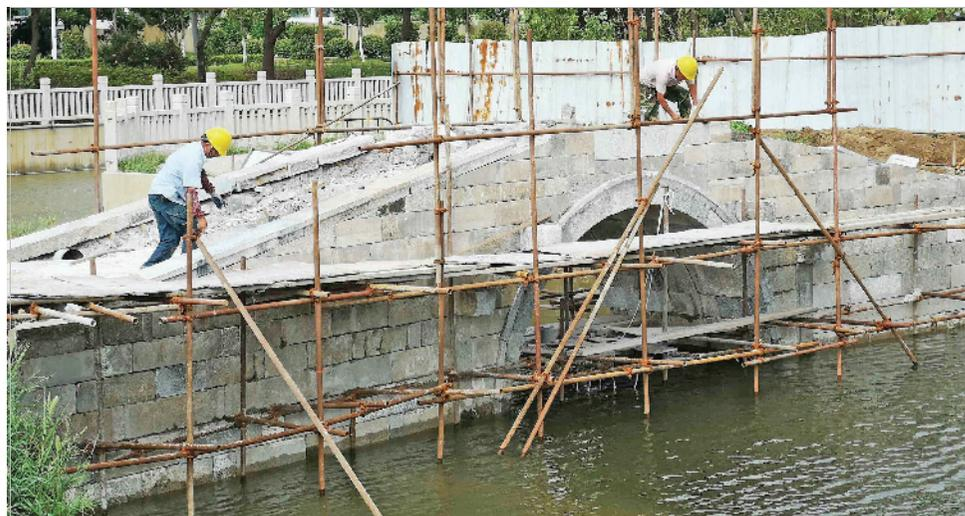
昨天,施工人员在胡埭镇将年久的古桥移建到富安新河。据悉,此桥名为刘塘桥,始建于明朝,至今已有 600 多年了,桥长 15 米,宽 2.4 米。(陈大春 摄)
