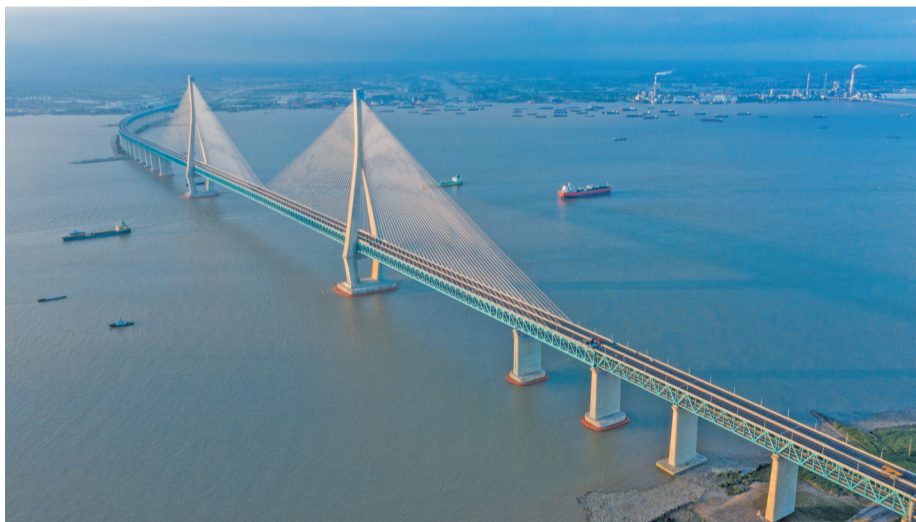
图为沪苏通长江公铁大桥(6月29日摄，无人机照片)，北起南通，南至张家港，公铁合建跨江正桥全长5827米，为集合高速公路、客货混线铁路、高速铁路的“三合一”过江通道。
