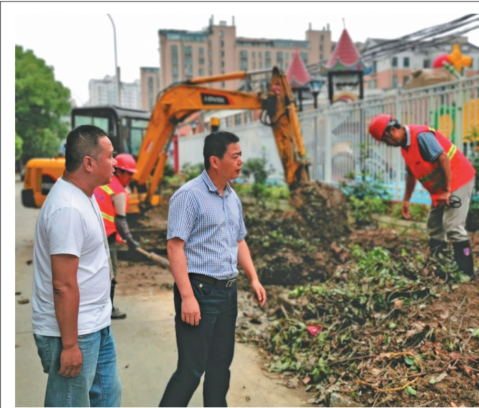
昨天，根据市人大代表《关于加快解决包张路交通拥堵问题的建议》，尤渡社区投入2000多万元，对社区包张路升级改造，解决该道路拥堵、破损、下雨积水等问题，为居民群众出行创造良好的道路交通环境。
