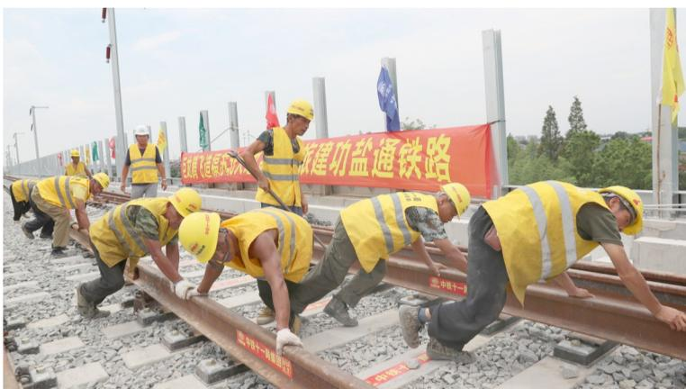
8月7日,工人在盐通高铁最后一组无缝钢轨铺设现场忙碌。当日,由中铁十一局三公司施工的盐通高铁全线轨道正式铺通。
