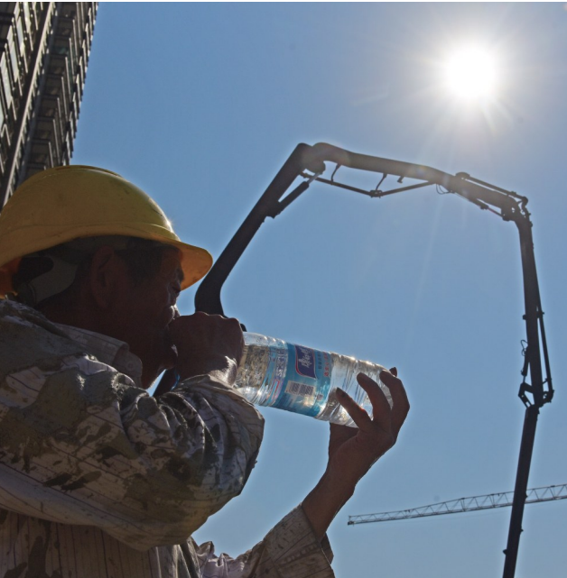
在太湖新城一处建筑工地,一位工人在喝水。 (还月亮 摄)
