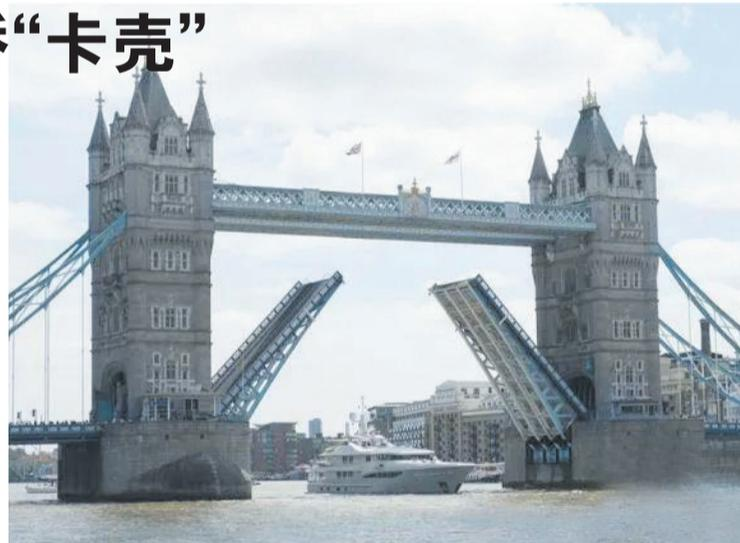
两端的塔楼大约高40米，塔楼内有水利机械装置，用于开合各重1000吨活动桥面，每年开合
