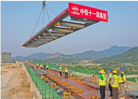
9月2日,中铁十一局施工人员在广东清远磁浮旅游专线进行轨道吊装作业。
