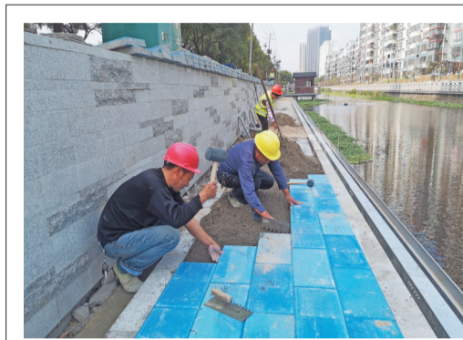
昨天,施工人员在大赛河亲水平台铺设彩色步道。全长3000多米、位于广益街道的大赛河经控源截污、清淤疏浚、景观绿化、生态治理等综合治理,焕然一新。 (陈大春 摄)
