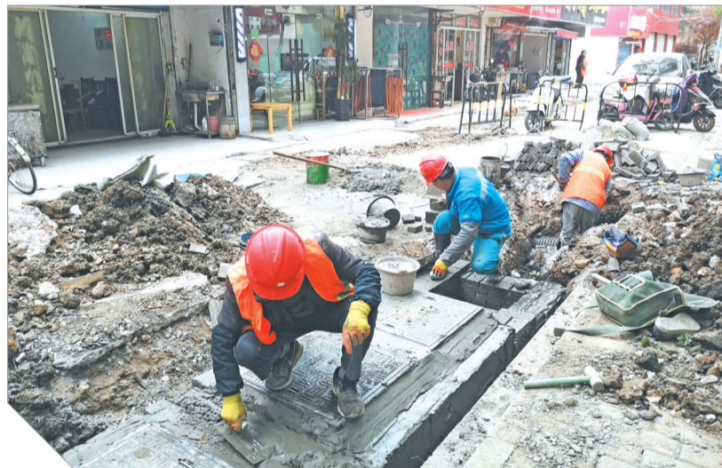
昨天，工人在五河新村进行雨污分流施工。梁溪区建设部门对该小区的沿街商店实行雨污分流全覆盖，进一步提升周边环境。 (陈大春 摄)
