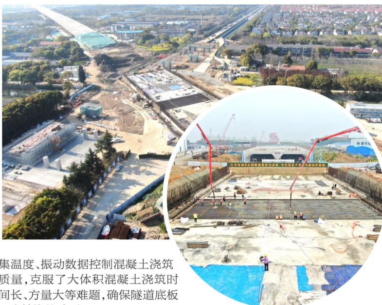
集温度、振动数据控制混凝土浇筑质量,克服了大体积混凝土浇筑时间长、方量大等难题,确保隧道底板一次性浇筑成型。
