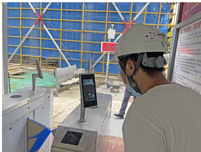
尚贤万科小学工地，工人通过人脸识别进入工地
