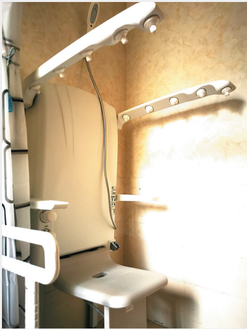
80周岁的许月霞老人家里,刚刚经历了一番适老化改造,卫生间换成了不容易滑倒、出水温和安全的一体化坐式淋浴器。
