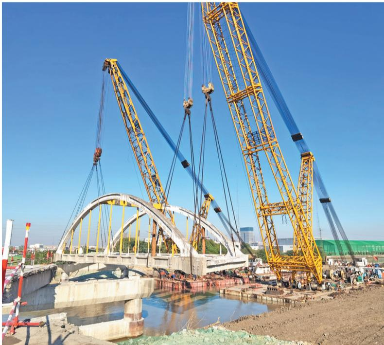
本报讯(晚报记者 蔡佳/文 朱浩/摄)昨天上午,历经1.5小时的紧张作业,跨径52米、重达720吨的锡澄运河黄石大桥老桥系杆拱在两艘500吨以上的浮吊船联合起吊下,成功拆除到预定位置。这标志着黄石大桥老桥拆除过程中安全风险最大的系杆拱整体吊装工作顺利完成,黄石大桥拆旧建新进入关键阶段。老桥拆除的同时,新桥建设将全面提速。
