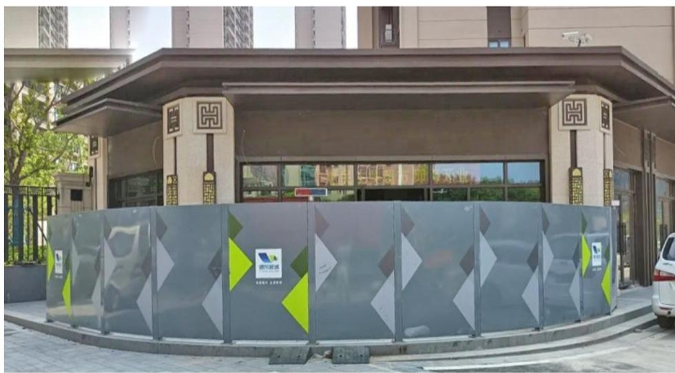
“没想到围挡也能这么靓丽！”昨天下午在锡山区府北路一写字楼一楼，一处店面的小型施工区域前增加的浅灰底色金属围挡吸引了不少过路者的目光，这种可开合的新型围挡不仅能阻挡扬尘，还具有轻便安全以及高颜值的优点。据悉，近日，锡
