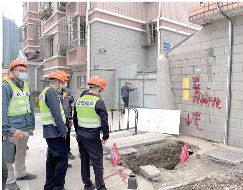
在高浪西路快速化改造01标段,联合督查组在工地围挡上以及燃气管线周边都看到了明确的燃气警示标识,标明地下有燃气管线,严禁私自开挖。燃气管道标志桩上面有管线的走向标识,如果施工或者是开挖,需要提前与燃气公司取得联系,查明管线的具体位置和走向。
