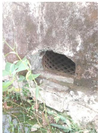
老宅山墙墙根处的通风透气孔
