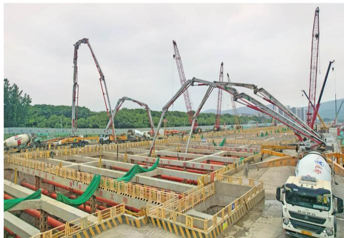
成部分,自1月9日首段底板浇筑以来,历时140多天,完成主线隧道基坑封底。“主线隧道基坑为异形基坑,最大宽度60.4米,最深26.2米”,唐政浙说,为了确保主体结构的施工进度,建设团队不断优化施工方案,积极组织施工,严格把控施工安全和浇筑质量,并且创新了“防尘天幕”系统打造“绿色”工地,为多面同步施工提供了有力后盾。
