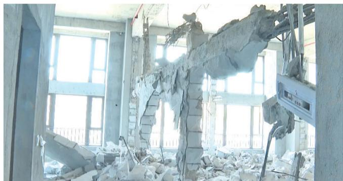
近日,广东肇庆四会市悦悦广场悦公馆的业主爆料,其公寓二楼的42套房被一位业主全部买了下来,准备把墙体全部打通装修成娱乐场所。6月4日,记者来到这家公寓,在二楼位置看到,现场的确可以用“满目疮痍”来形容,多面墙体被打掉,多条柱子被截断,裸露出钢筋。据悉,涉事二层面积约1800平方米,目前施工队拆除的面积接近三分之一。有业主告诉记者,为方便运输二楼的装修建筑垃圾,施工队直接打穿了一楼的天花板。6月6日,四会市住房和城乡建设局发布情况说明:初步统计已违规施工约700平方米,责令其立即停止施工并限期改正。(来源:广东台)
