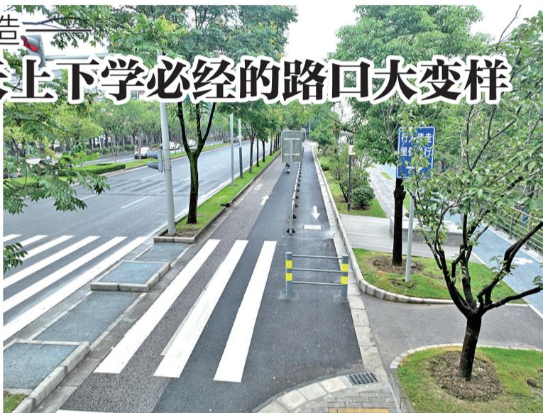
负责人介绍,本次路口改造将太湖大道新村路口西侧80米人行道改造成非机动车道,并用隔离护栏与现在的非机动车道分隔,为非机动车提供“逆行车道”。
