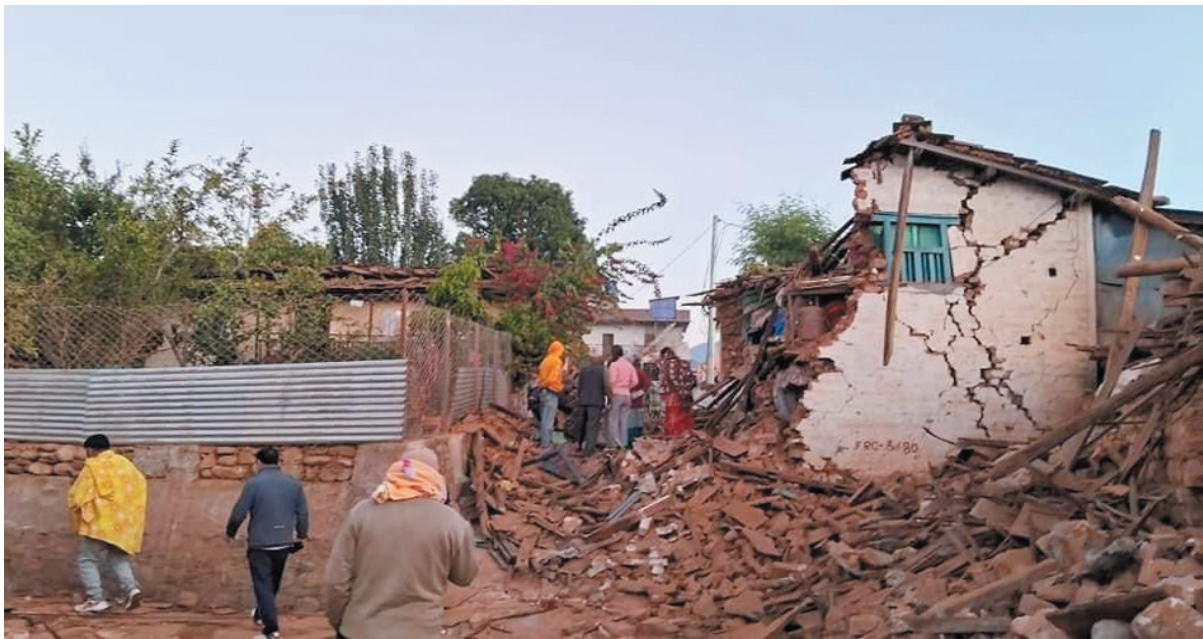
这是11月4日在尼泊尔西部扎泽尔果德拍摄的被地震损毁的房屋。(新华社)
