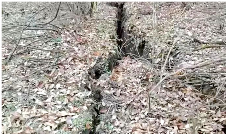
李先生去年拍摄的山顶上的裂缝。(受访者供图)
