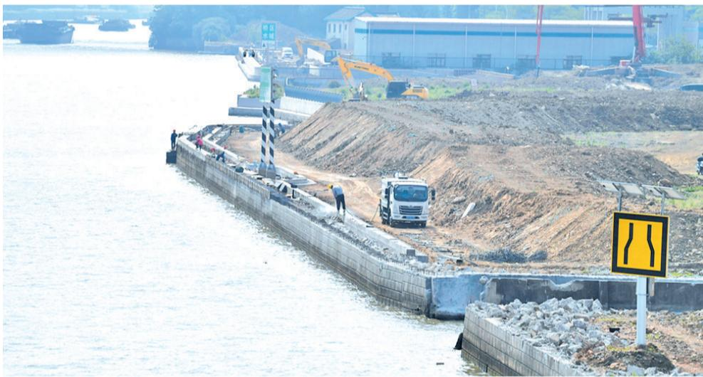
昨日，在钱桥街道京杭大运河堤防整治提升工程施工现场，工人正抓紧加高加固堤防、新建堤防挡墙，确保安全度汛。
