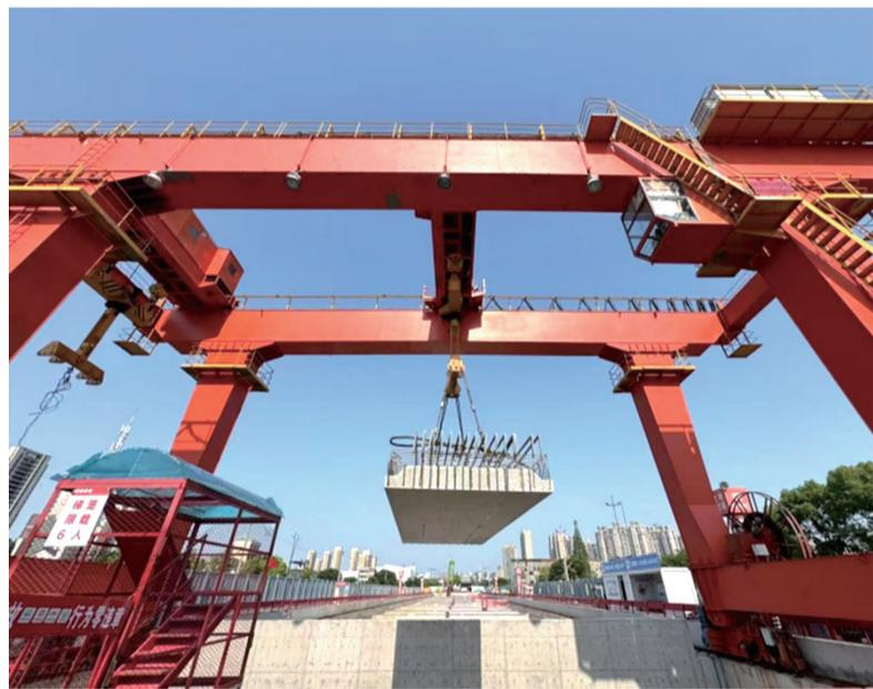
本报讯 6月19日上午，无锡地铁5号线新阳路站、坊明路站双双封顶。这两个地铁站是国内首批大规模应用装配叠合整体式技术建造的地铁站，目前全部拼装完成。
