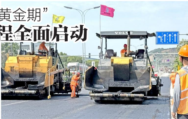
充分黏合,提升路面密实度,增强抗压耐磨性能,有效减少车辙、开裂等病害,延长道路使用寿命。
