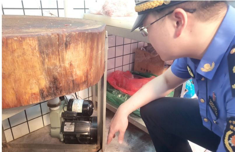
浴室经营方表示，水泵是维持其水循环的关键设备，唯一的进水通道依赖于此，关停将严重影响经营。既然水泵不能停，那能否将它“请走”？城管中队与瑞丰社区工作人员经过多次实地调研和协商，提出了一个创新方案：实施“水泵内迁+管道延伸”改造，核心思路是将暴露在室外的噪音源——水泵，迁移至室内墙体内部，并加装隔音措施，让它远离居民楼。
