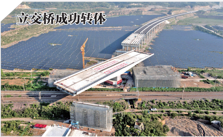
这是8月11日拍摄的河南省济源市沿太行山高速公路跨焦柳铁路立交桥转体施工现场（无人机照片）。当日，由中铁大桥局承建的河南省济源市沿太行山高速公路上跨焦（作）柳（州）铁路立交桥成功转体。转体主梁总长130米，总重量达2.1万吨。
