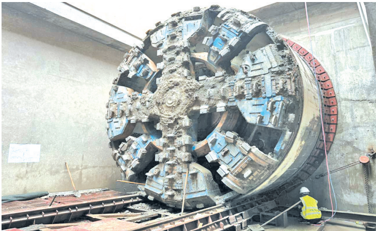
坊明路站—新阳路站左线贯通。
