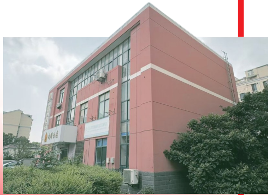
惠山区堰桥街道金惠社区“曾钰楼”。
