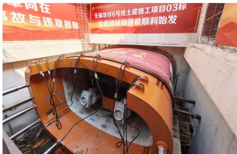
设计，断面土体切削覆盖率高达93.16%，具备更强的地质适应性和掘进效率。设备设有30个减摩泥浆注浆孔和7个前部土压传感器，最大工作压力0.4兆帕，有效保障顶进施工的稳定与安全。
